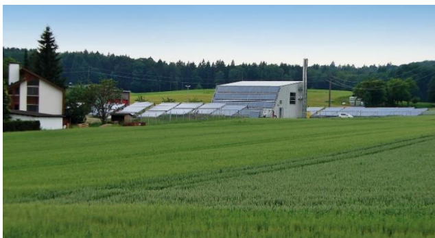
Pav. 34: Katilinė su integruotais saulės šildymo kolektoriais Büsingene, Vokietija (Šaltinis: Solites, D. Rutz)
