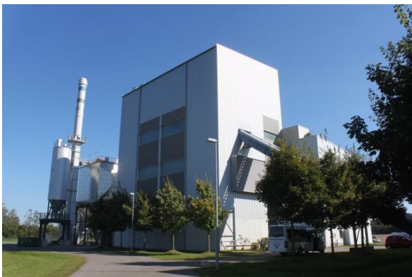
Pav. 44: Kogeneracinė jėgainė, naudojanti medienos drožles (7,8MW el ir 15MW šil galios), Augsburgas, Vokietija (Šaltinis: D. Rutz)
