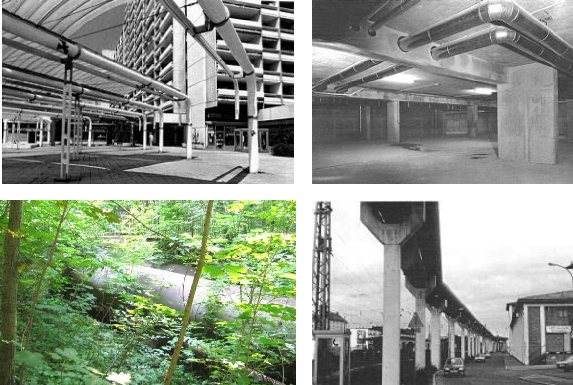
Pav. 31: Orinių vamzdynų pavyzdžiai (Šaltinis: AGFW, 1987)
