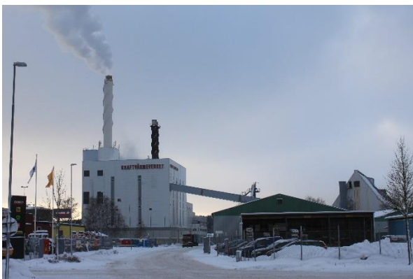
Pav. 43: Kogeneracinė jėgainė, naudojanti medienos drožles iš medienos atliekų, Enšioingas, Švedija (Šaltinis: D. Rutz)
