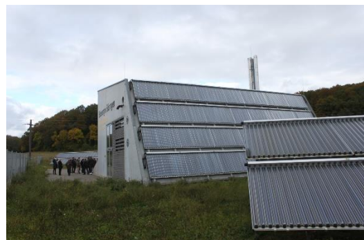
Pav. 34: Katilinė su integruotais saulės šildymo kolektoriais Büsingene, Vokietija (Šaltinis: Solites, D. Rutz)
