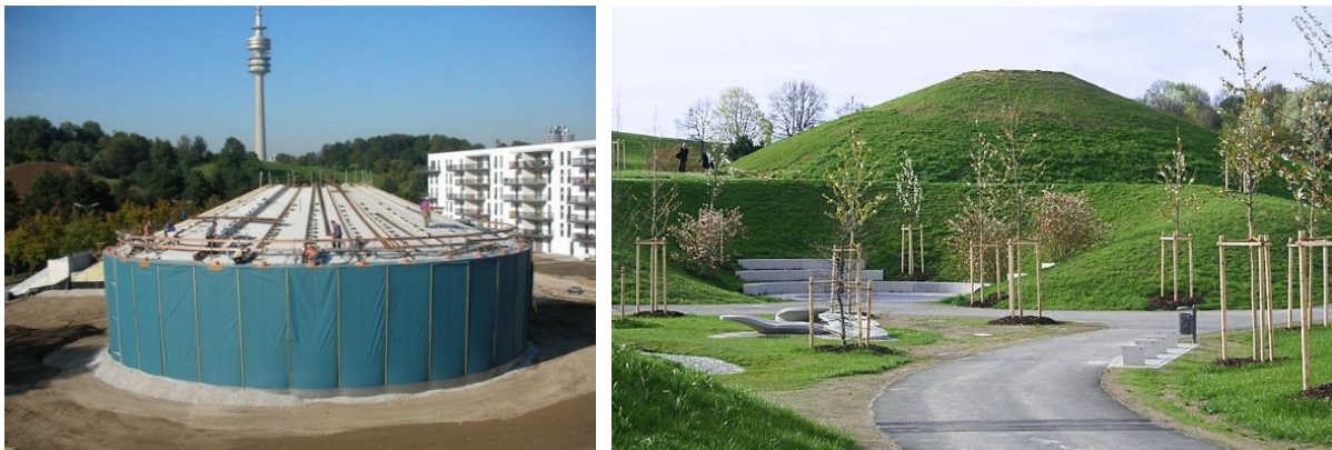
Pav. 57: Uždaro rezervuaro tipo ŠAT, įrengta iš surenkamųjų betoninių elementų, tūris - 5,700 m 3 , Miunchenas, Vokietija (Šaltinis: Solites)
