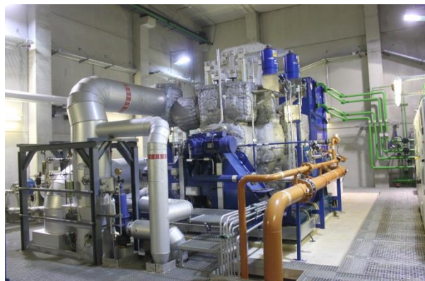
Pav. 44: Kogeneracinė jėgainė, naudojanti medienos drožles (7,8MW el ir 15MW šil galios), Augsburgas, Vokietija (Šaltinis: D. Rutz)
