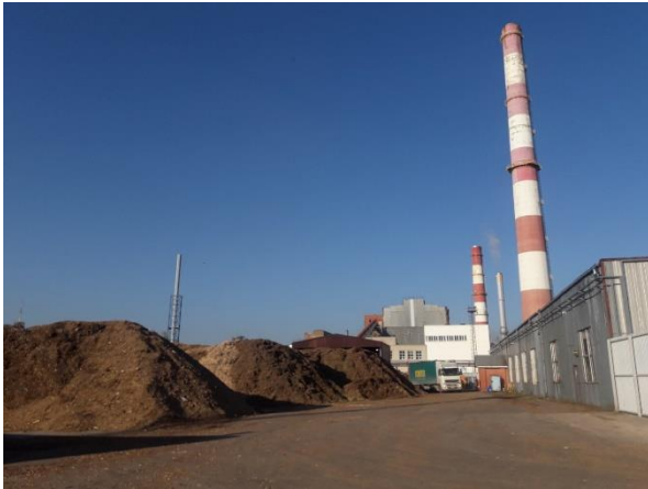
Pav. 42: Kogeneracinė jėgainė, naudojanti medienos drožles, Vilnius, Lietuva (Šaltinis: D. Rutz)
