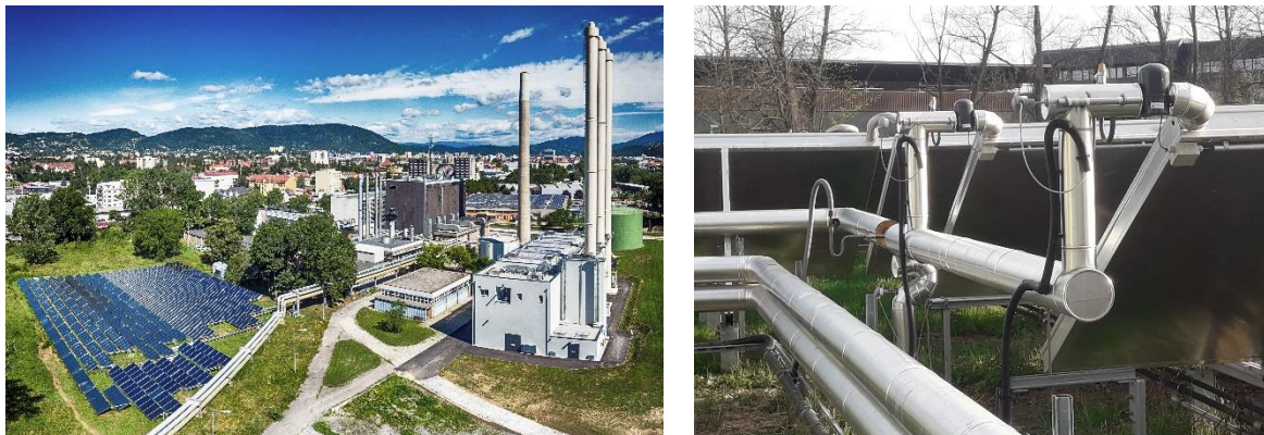
Pav. 35: Saulės šilumos kolektorių laukas kuris prijungtas prie CŠT, Gracas, Austrija (Šaltinis: SOLID, D. Rutz)
