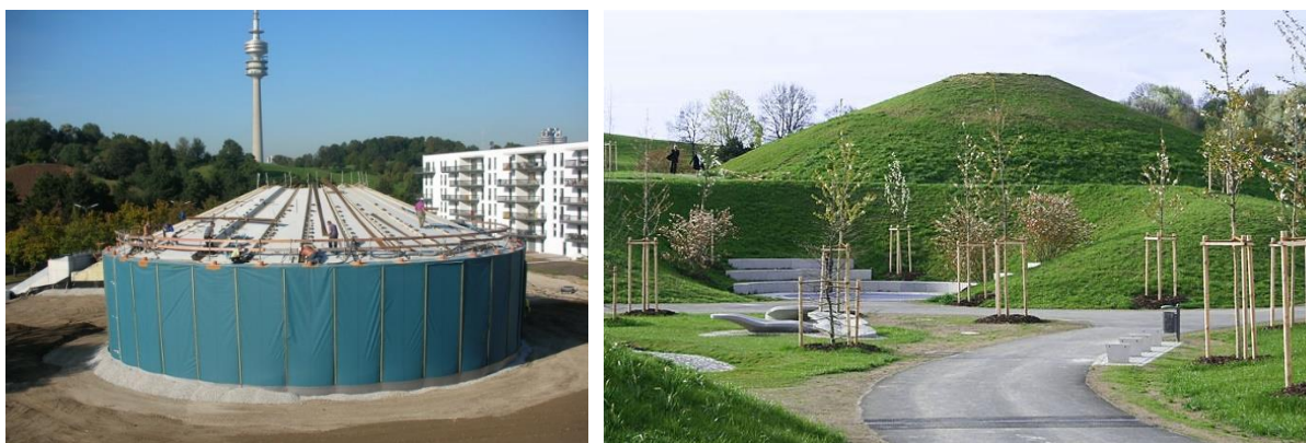
Slika 48: Toplinski spremnik sa 5.700 m 3 volumena vode izgrađen od montažnih betonskih elemenata u Münchenu, Njemačka (u izgradnji i finaliziran, Izvor: Solites)
