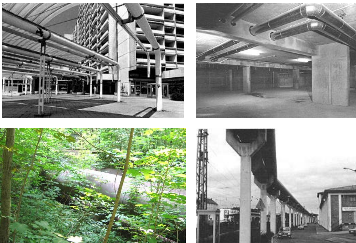
Slika 22: Primjeri nadzemnih i visećih cjevovoda (Izvor: AGFW, 1987)
