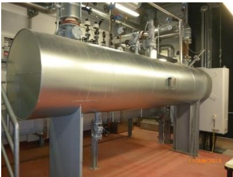
Slika 44: Električni protočni grijač (Izvor: Klöpper-Therm GmbH & Co.KG)
