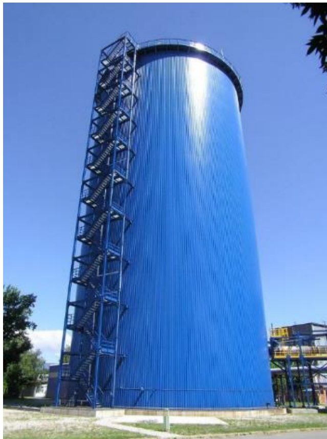
Slika 46: Toplotni spremnik koji nije pod pritiskom u SDG u Zagrebu (Izvor: www.pogledaj.to )
