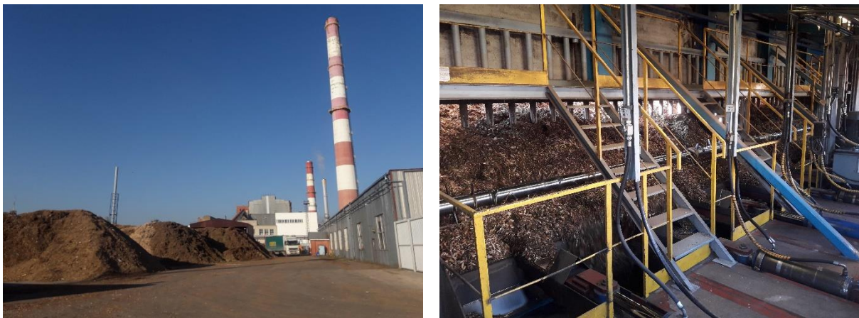
Slika 33: CHP postrojenje u Salcininkai, Litvanija, u kojem je kotao na biomasu (5 MW th ) zamijenio jednu od tri gasne CHP jedinice. Preostale dvije kogeneracijske jedinice na prirodni gas imaju kapacitet od 3,5 MW th i 6 MW th (Izvor: D. Rutz)
