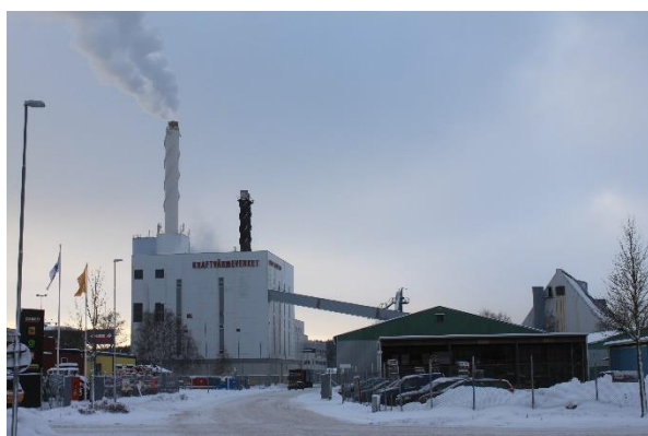
Slika 34: CHP kogeneracijska elektrana Ena Energie u Enköpingu koja koristi drvenu sječku iz otpadnog drveta (desno) i iz panjeva kratke rotacije (SRC) (Izvor: D. Rutz)
