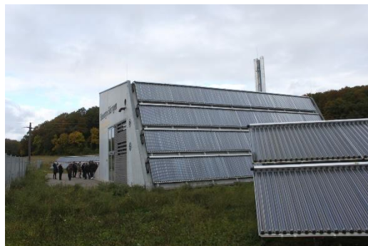
Slika 25: Toplinsko postrojenje sa solarnim termalnim kolektorima u selu Büsingen, Njemačka (Izvori: lijevo: Solites; desno: D. Rutz)
