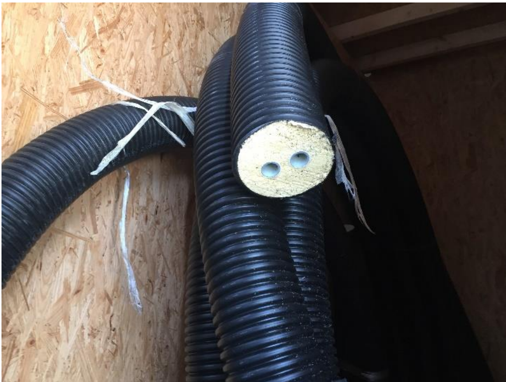
Slika 5: Niskotemperaturni SDG omogućavaju korištenje plastičnih cijevi (dvocijevni), koje su jeftinije i lakše se montiraju zbog fleksibilnosti (Izvor: B. Doračić)
