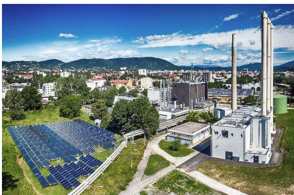
Slika 26: Polje solarnih termalnih kolektora u Grazu, Austrija, koje napaja mrežu SDG Graza (Izvori: lijevo: SOLID; desno: D. Rutz)
