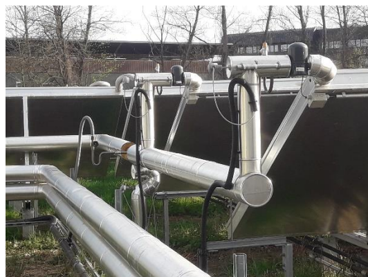
Slika 26: Polje solarnih termalnih kolektora u Grazu, Austrija, koje napaja mrežu SDG Graza (Izvori: lijevo: SOLID; desno: D. Rutz)
