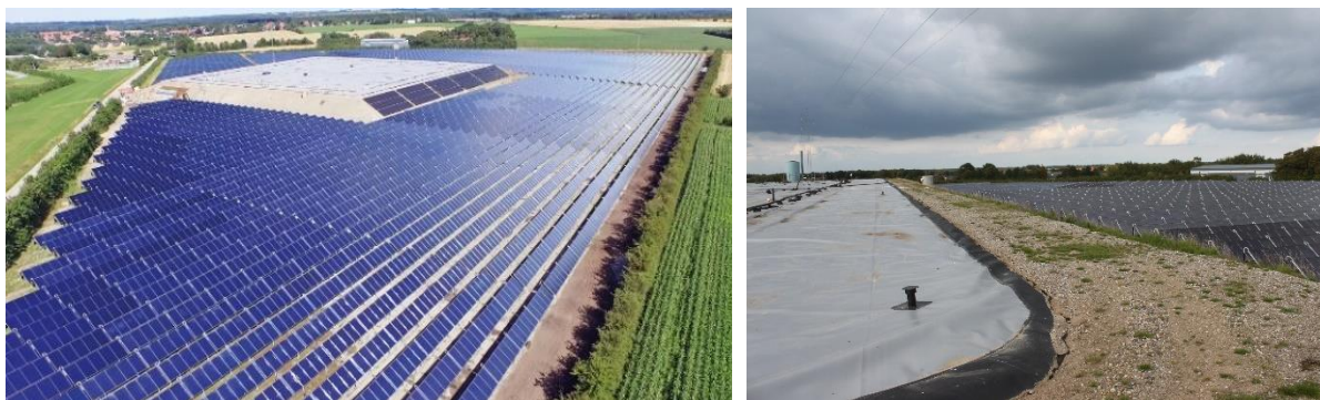
Slika 27: Polje solarnih kolektora u Gramu, Danska, sa sezonskim podzemnim spremnikom topline (Izvori: lijevo: Gram Fjernwärme, desno: D. Rutz)
