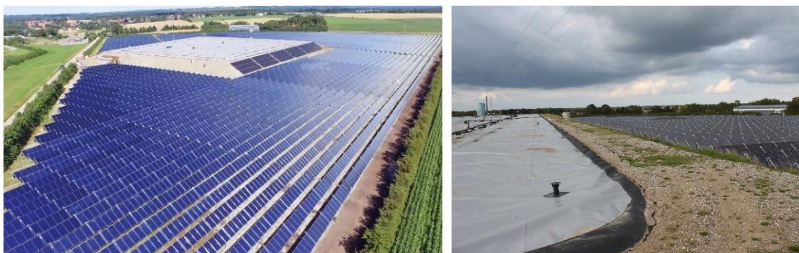
Figur 36: Solvarmeanlæg i Gram, Danmark, med en sæsonbestemt termisk energilagring (Kilder: venstre: Gram Fjernvarme, højre: D. Rutz)
