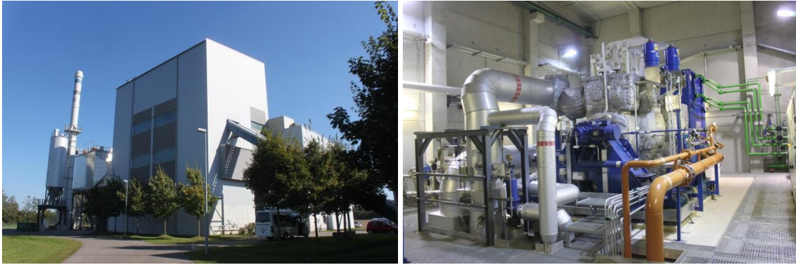
Figur 44: Træflis fyret kraftvarmeværk og dets damp turbine fra Stadtwerke Augsburg Energie GmbH i Tyskland (kapacitet: 80.000 t / træflis, 7,8 MW el, 15 MW varme) (Kilde: D. Rutz)
