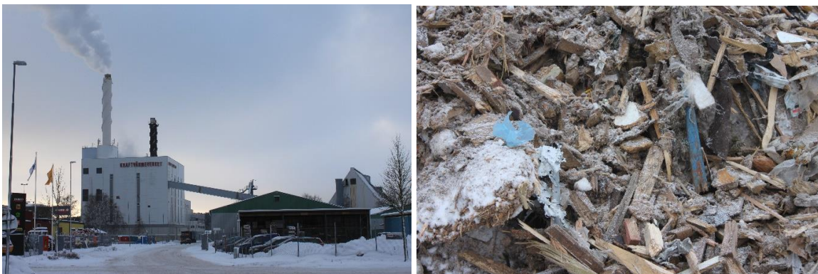
Figur 43: Ena Energies Kraftvarmeværk i Enköping bruger træflis fra affaldstræ (højre) og fra kort rotationstræ (SRC) (Kilde: D. Rutz)
