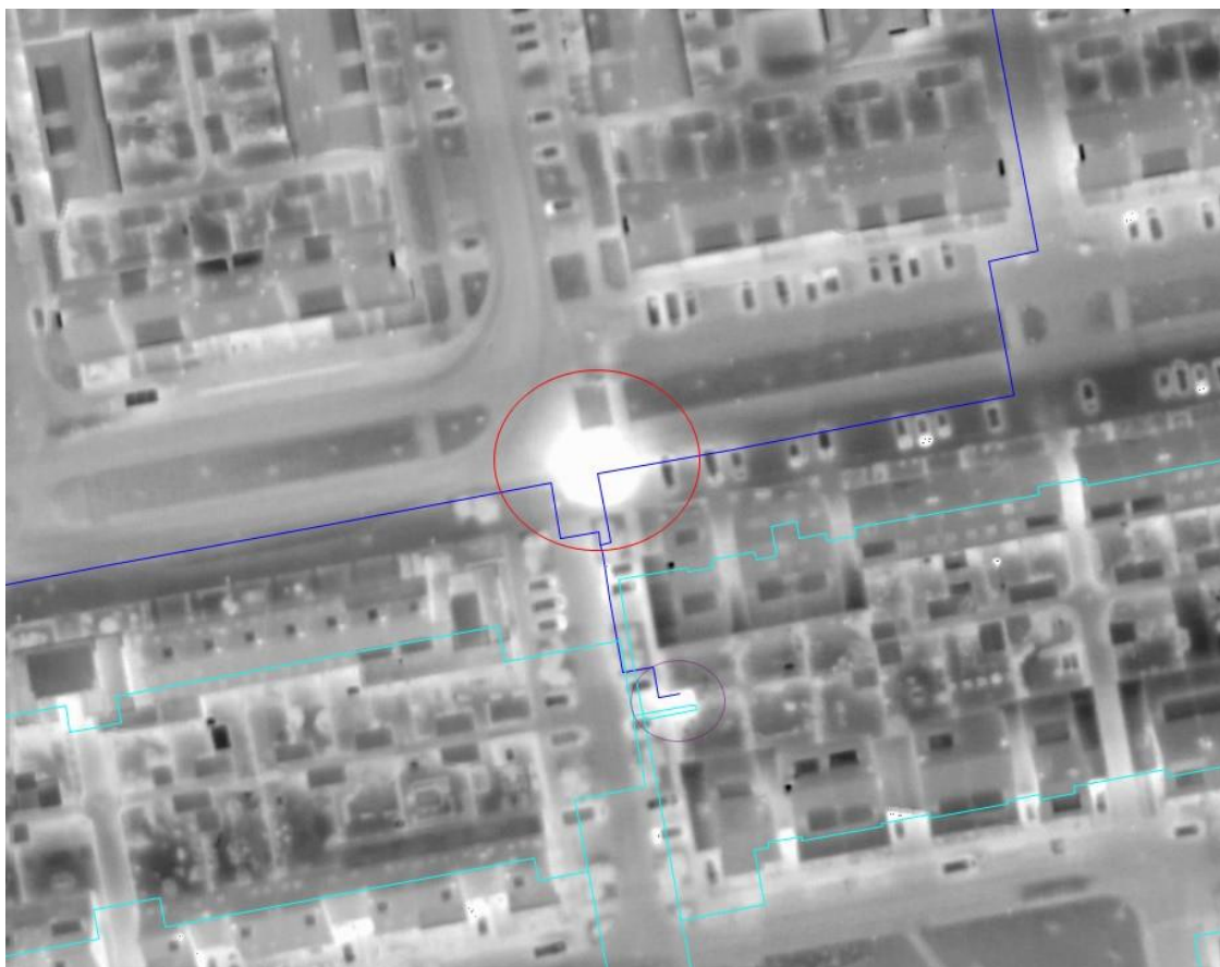
Figur 20: Termografi af et fjernvarmenet, der viser en større lækage på en rørledning (Kilde: COWI)
