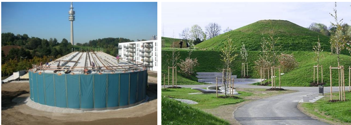
Figur 57: Tank til varmelagring med 5.700 m 3 vandvolumen bygget af præfabrikerede betonelementer i München, Tyskland (under opførelse og færdiggørelse, Kilde: Solites)
