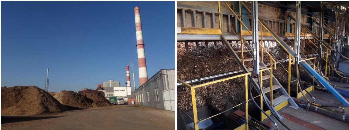
Figur 42: Kraftvarmeværk i Salcininkai, Litauen, hvor en biomasse-kedel (5 MW varme) erstattede en af de tre naturgas-kraftvarmeværker. De resterende to gas-kraftvarme-enheder har en kapacitet på 3,5 MW og 6 MW varme (Kilde: D. Rutz)
