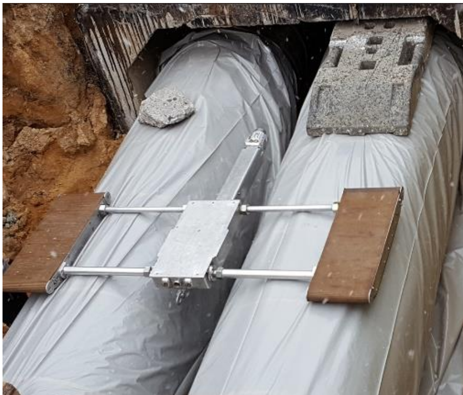
Figur 27 Visuel inspektion med "The Crawler Eye" af det tyske Institut für Angewandte Bauforschung Weimar gGmbH (Kilde: AGFW)
