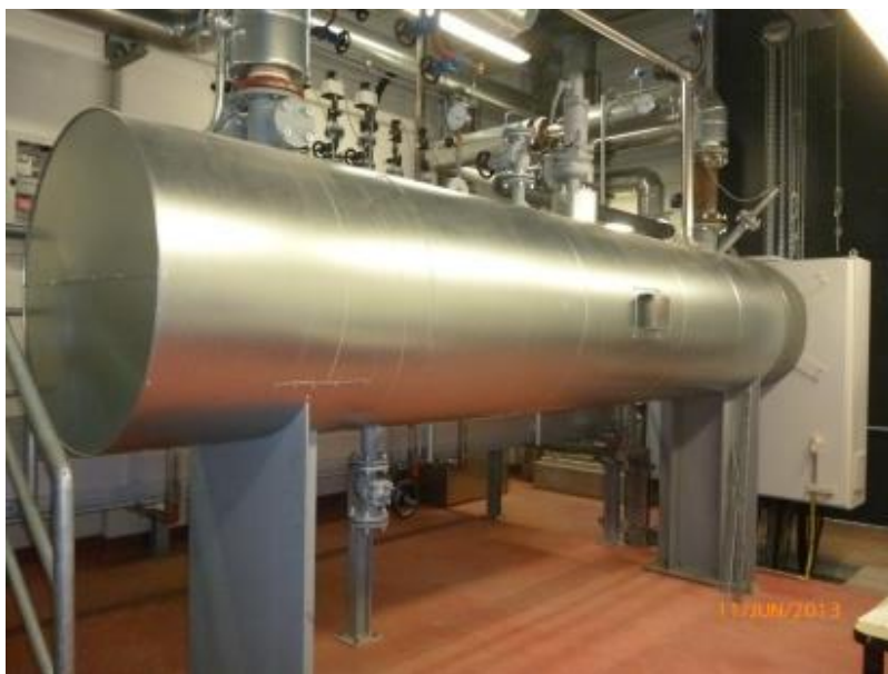
Figur 53: Elektrisk gennemstrømnings-vandvarmer (kilde: Klöpper-Therm GmbH & Co.KG)
