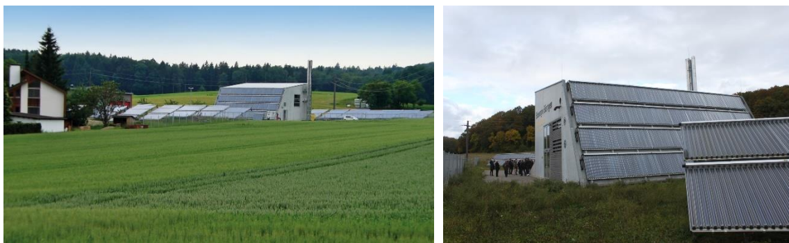
Figur 34: Solfjernvarmeanlæg med solfangere i Büsingen, Tyskland (Kilder: venstre: Solites; højre: D. Rutz)
