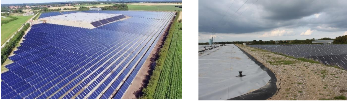
Figura 36: Campo di collettori solari a Gram, in Danimarca, con stoccaggio stagionale dell'energia termica sotterraneo (Fonti: sinistra: Gram Fjernwärme, destra: D. Rutz)
