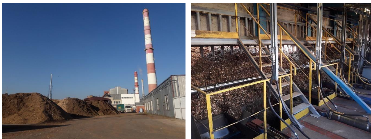
Figura 42: Centrale di cogenerazione di Salcininkai, in Lituania, dove la caldaia a biomassa (5 MWh) ha sostituito una delle tre unità di cogenerazione a gas naturale. Le due unità rimanenti hanno una capacità di 3,5 MW th e 6 MW th (Fonti: D. Rutz)
