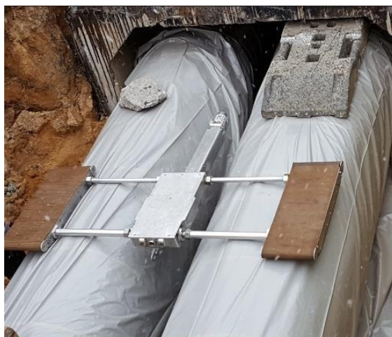
Figura 27 Ispezione visiva con il “Crawler Eye” dell’Institut für Angewandte Bauforschung Weimar gGmbH tedesco (Fonte: AGFW)
