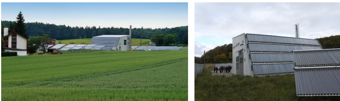
Figura 34: Impianto di riscaldamento con collettori solari termici nella cittadina di Büsingen, in Germania (Fonti: sinistra: Solites; destra: D. Rutz)
