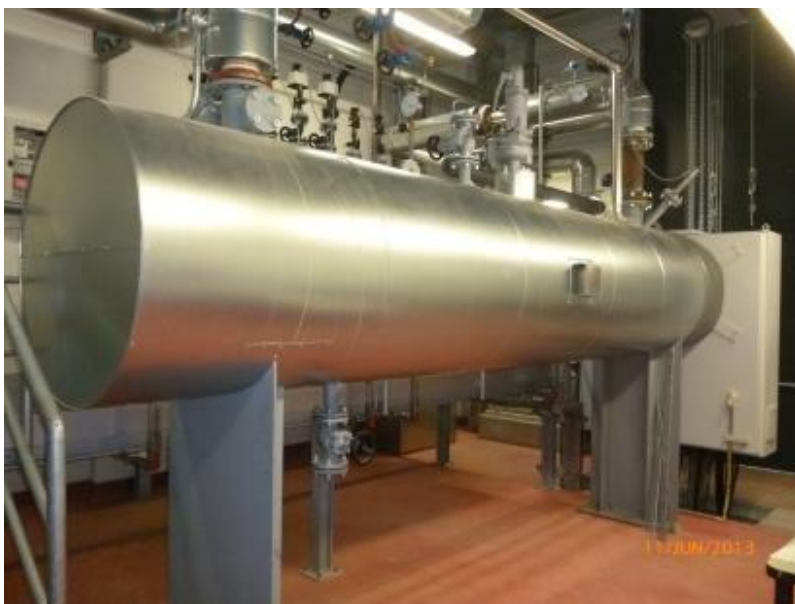
Figura 53: Riscaldatore di flusso elettrico (Fonte: Klöpper-Therm GmbH & Co.KG)
