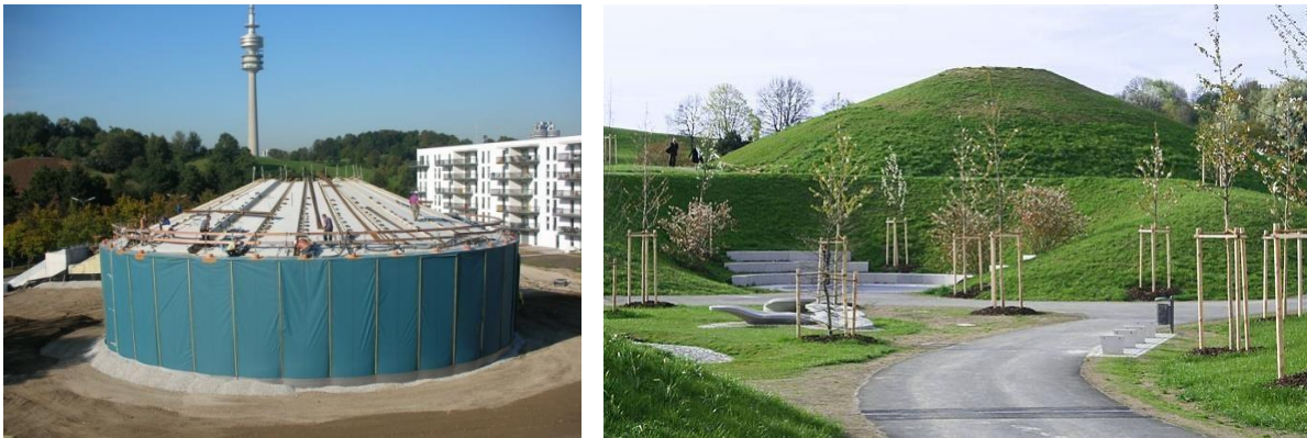
Figura 57: Serbatoio per lo stoccaggio dell'energia termica da 5.700 m 3 d'acqua costruito con elementi pre-fabbricati a Monaco, in Germania (in costruzione e terminato, Fonti: Solites)
