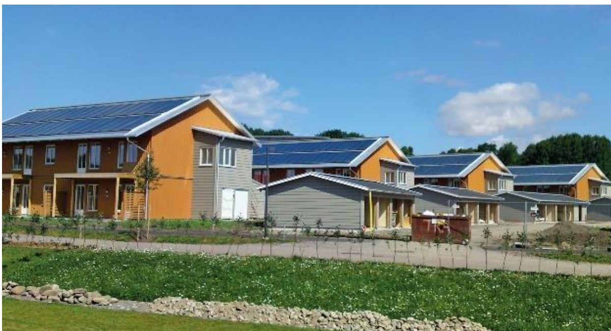
Figura 33: TLR solare nella zona residenziale di Vallda Heberg, in Svezia (Fonte: Jan-Olof Dalenbäck)
