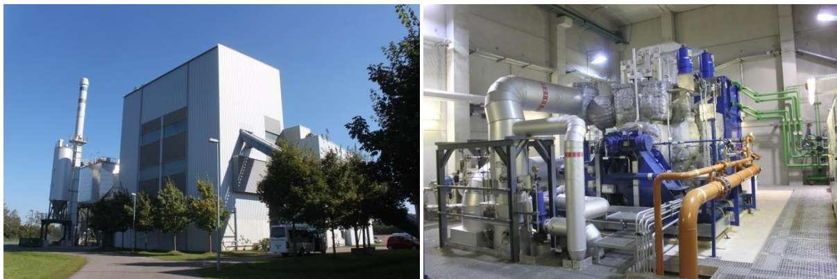
Figura 44: Centrale di cogenerazione a cippato e relativa turbina a vapore di Stadtwerke Augsburg Energie GmbH in Germania (capacità: 80.000 t/a cippato; 7,8 MW el ; 15 MW th ) (Fonti: D. Rutz)
