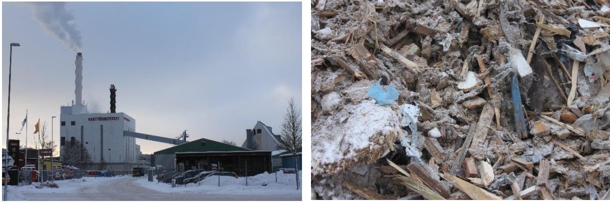
Figura 43: Centrale di cogenerazione di Ena Energie a Enköping, che utilizza cippato da legno di scarto (destra) e da bosco ceduo a rotazione rapida (Fonti: D. Rutz)
